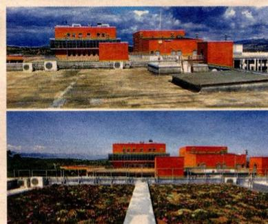
Installazione in cima al cubo 46C di Meccanica di UniCal di un cosiddetto "tetto a verde", cioè ricoperto di terra e vegetali. Sopra, prima dei lavori e, sotto, il tetto verde fiorito
